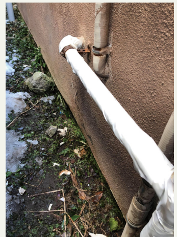
雨漏り調査工事 S低
