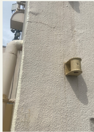
外壁塗装 防水 埼玉県
